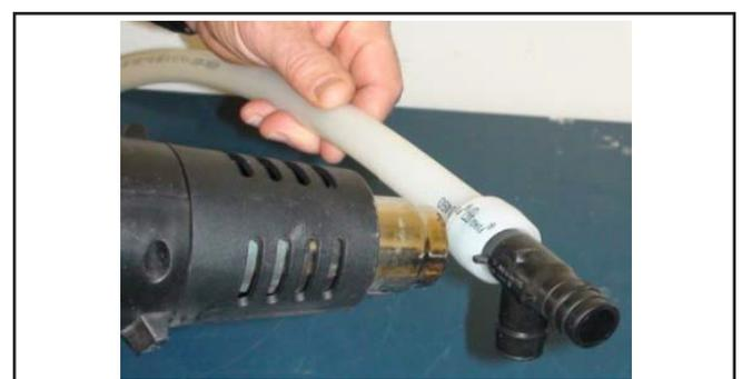
Figure 15 - Chauffage du tuyau
