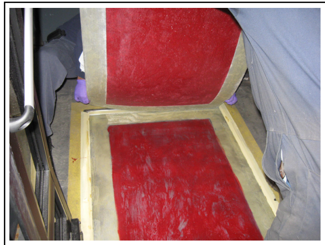
Figure A12 - Deux personnes nécessaires pour l'installation du recouvrement
