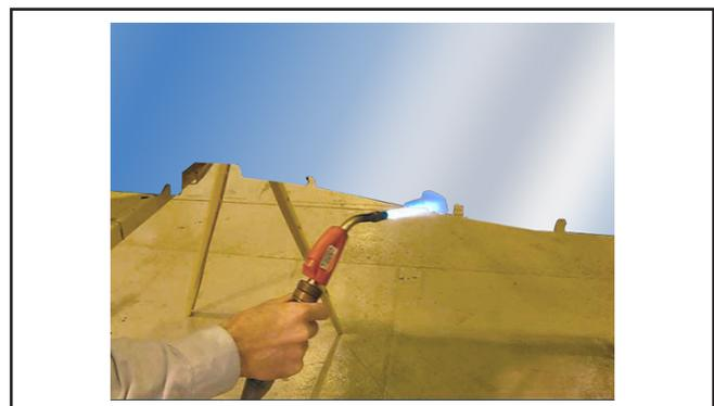
Figure 10 - Chauffer légèrement à la flamme la cage de roue
