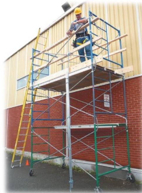
Échafaudage à cadres métalliques de 1,5 m de largeur
